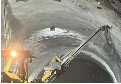
Şekil 4.4. SN bulon uygulaması
