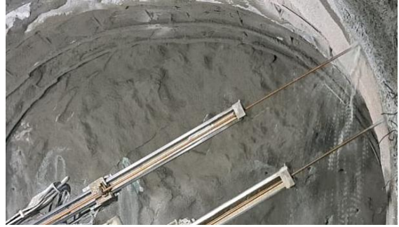
Şekil 4.5. IBO Bulon uygulaması
