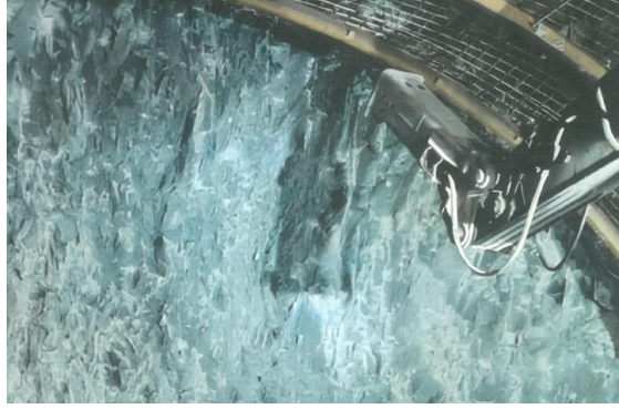
Şekil 4.2. Kuzey sol tüp, Km:6+182.10 ayna fotoğrafı
