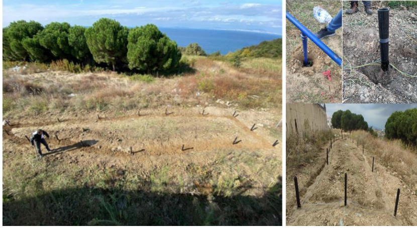
Şekil 5. Fiber optik kablo serilim adımları, sabitleme çubukları ve kablo konfigürasyonu
