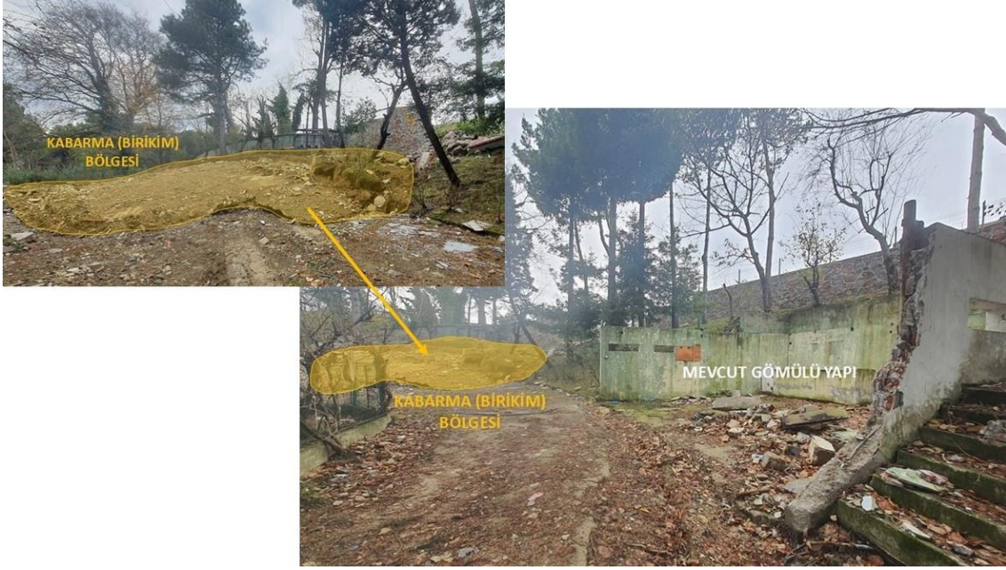
Şekil 5. Heyelan kabarma bölgesi ve mevcut gömülü yapı görünümü
