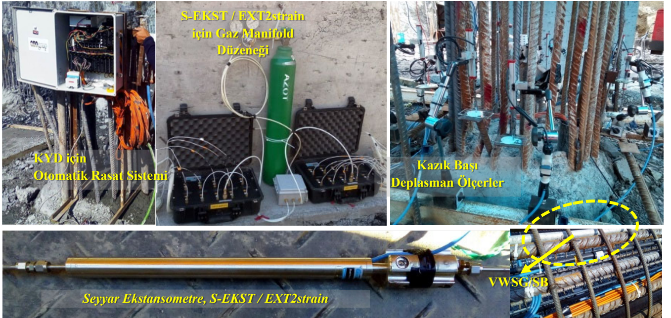
Şekil 6. TK-2 ve TK-3 Deney Kazıklarında (TİP-A ve TİP-B) yükleme deneyinde kullanılan ölçüm aletlerinden genel görünüş
