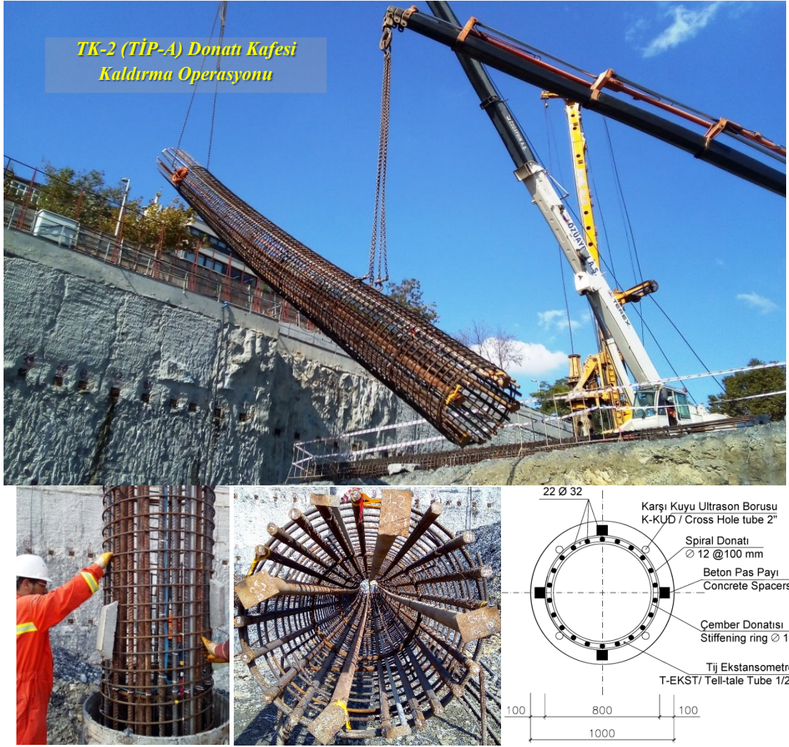
Şekil 3. Enstrümente edilmiş TK-2 deney kazığı (TİP-A) donatı kafesi genel ve detay görünüşü.
