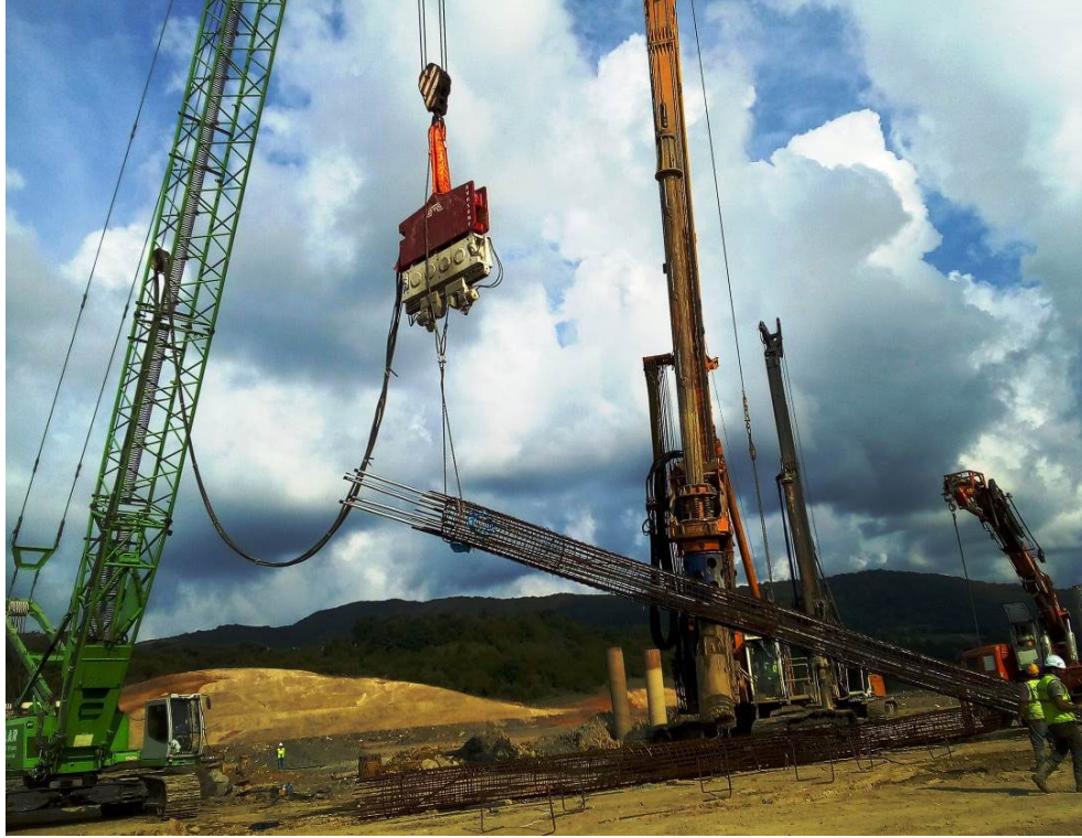
Şekil 4 Enstrümante edilmiş deneş kazığı donatı kafesi kaldırma operasyonu genel görünüş
