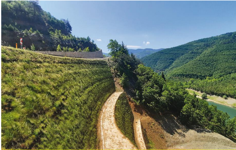
Şekil 3. 60 derece ön yüzey eğimli geogrid donatılı toprak şev (Bursa, Keles 2021)
