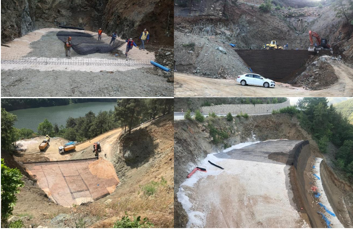
Şekil 7. Geoşev imalat aşamalarına ait görseller(Bursa, Keles 2020)
