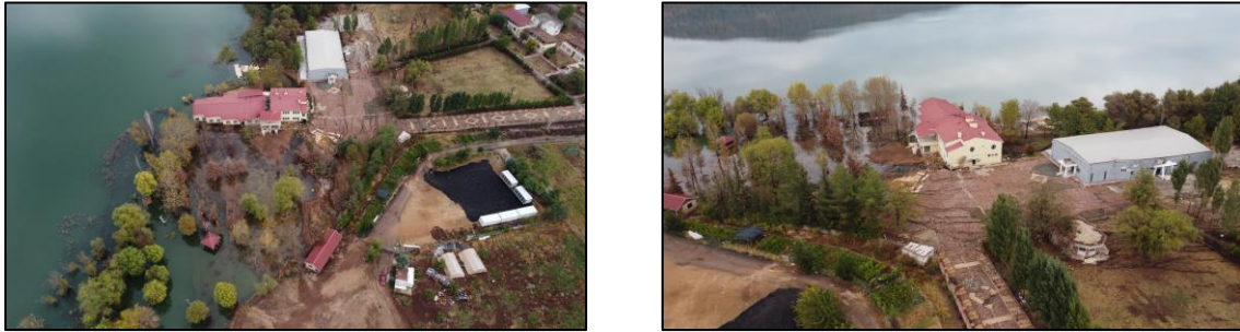
Şekil 6. Çalışma alanında gözlenen yatay düşey zemin deformasyonları
