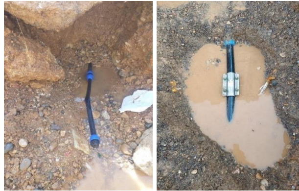
Şekil 4. 63 mm'lik yüksek yoğunluklu polietilen (HDPE) borunun onarım çalışması
