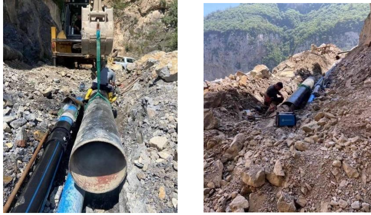
Şekil 3. Değirmendere bölgesinde boru onarım çalışmaları
