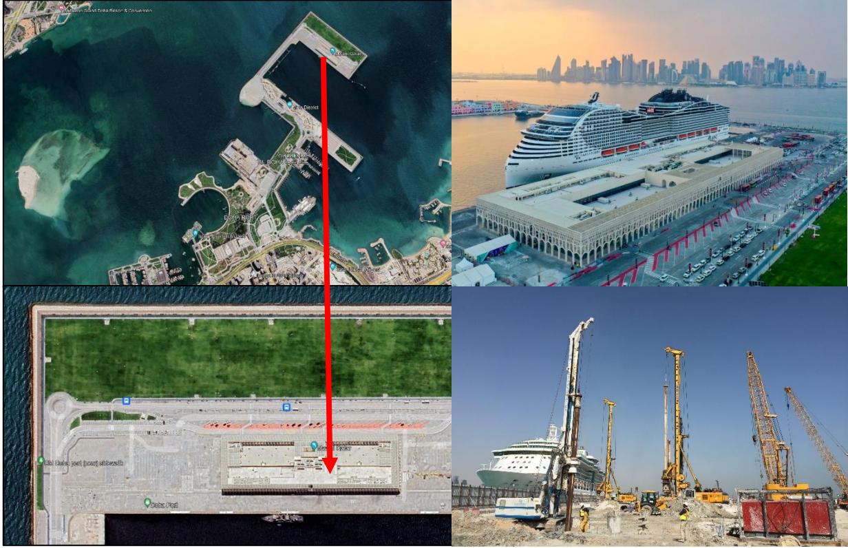
Şekil 1. Projenin konumu, güncel durumu ve kazık imalatı sırasındaki saha görseli
