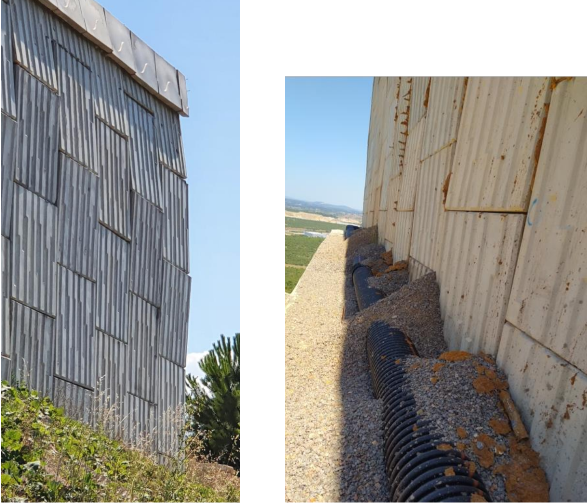
Şekil 3. (a) Duvarda Hareketler ve (b) Sistem Dışına Taşınmış Dolgu Gerci
