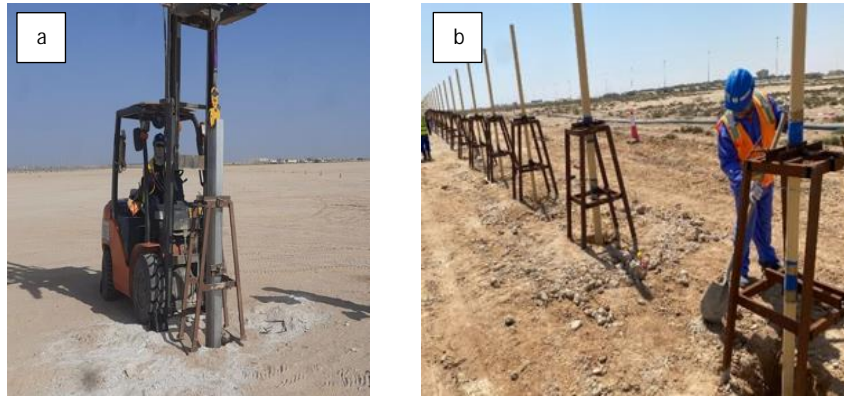
Şekil 4. Profillerin Kılavuz Yardımı ile yerleştirilmesi
