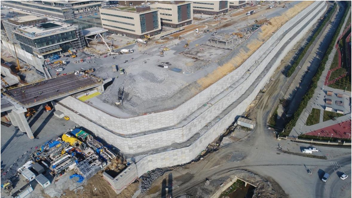
Şekil.7. Toprakarme Duvar Genel Görünümü-İnşaat Aşaması
